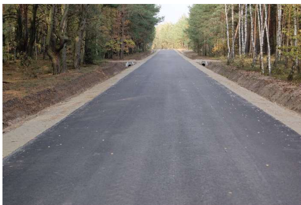
Zdjęcie nr 1 Budowa drogi gminnej nr 632026P Kolonia Obory – Studzianka
