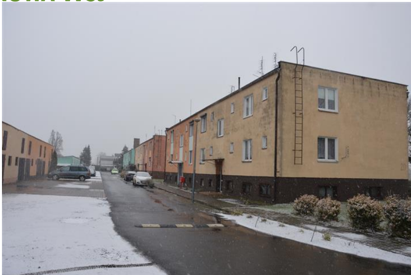
Bloki mieszkalne na terenie RSP
