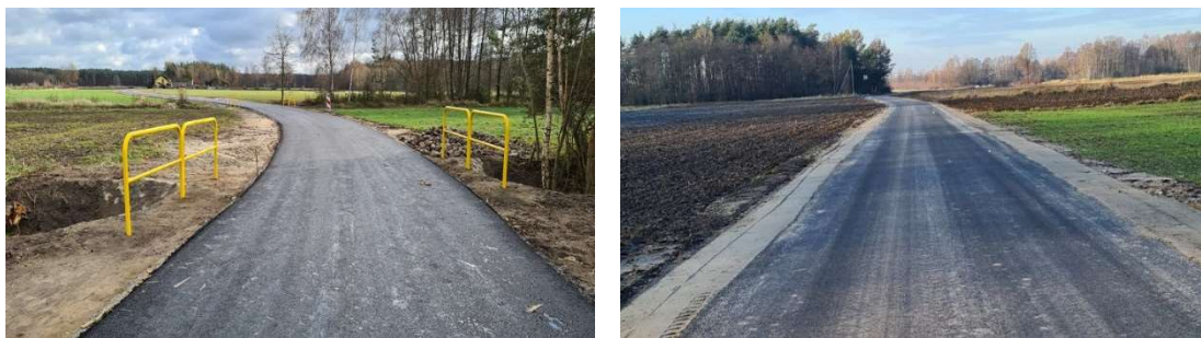
Zdjęcia UG – droga gminna nr 632082 P w m. Kolonii Obory
