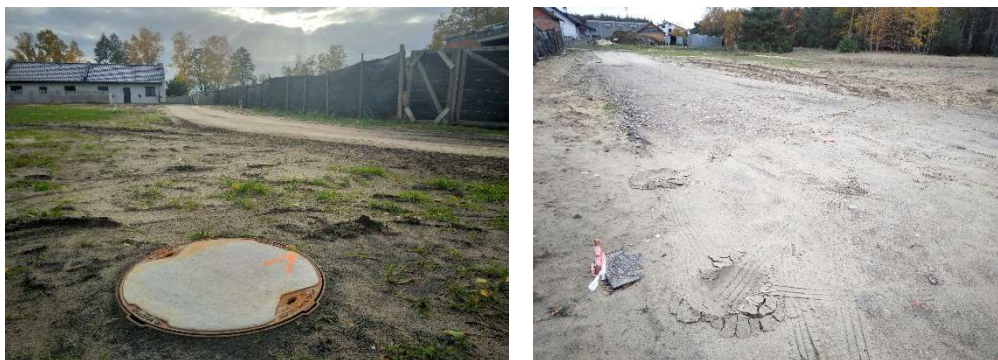
Zdjęcia UG – sieć kanalizacji sanitarnej w Gizalkach ul. Leśna
