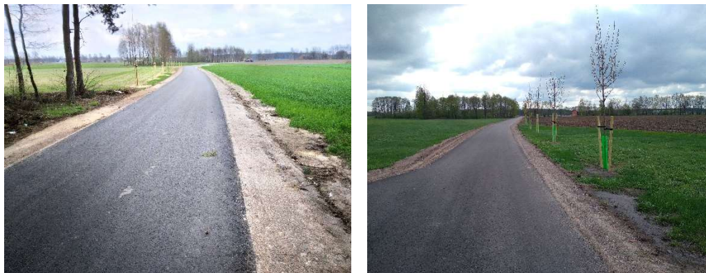
Zdjęcia UG – droga gminna nr 632071P w m. Wierzchy
