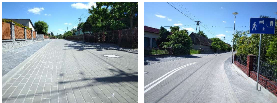
Zdjęcia UG – droga gminna ul. Wodna w Giząłkach
