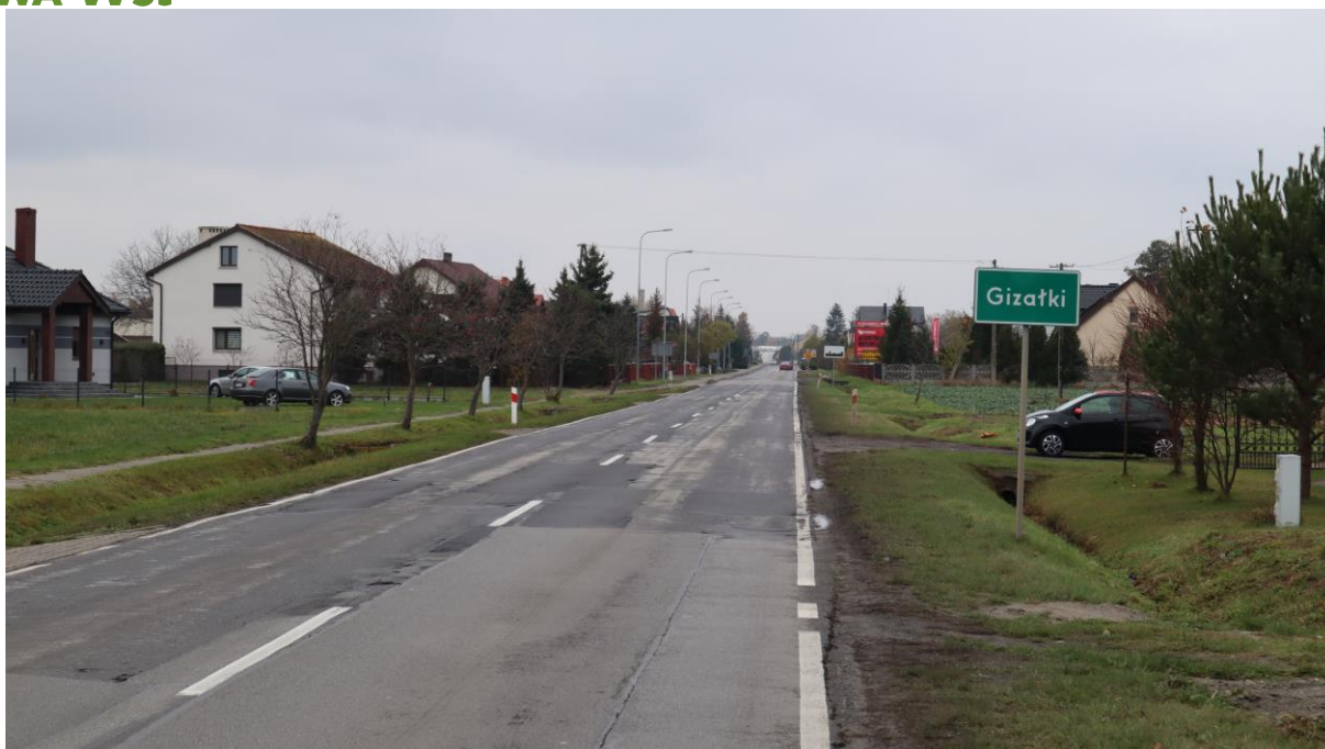
Wjazd do Gizałek od strony Kalisza drogą wojewódzką nr 442.
