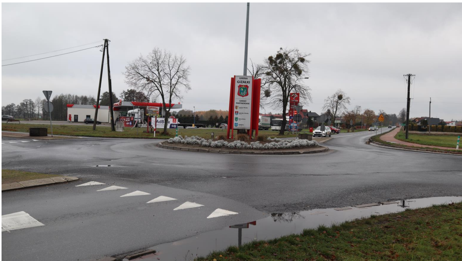
Infrastruktura drogowa w Gizalkach: droga powiatowa po przebudowie oraz rondo na skrzyżowaniu dróg wojewódzkich nr 442 i 443.
